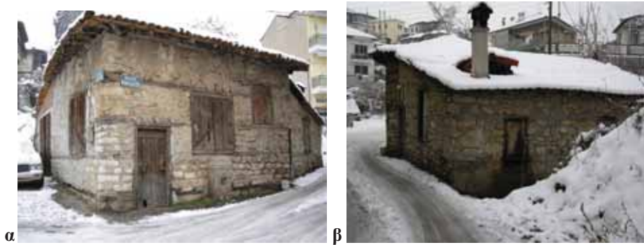
Εικ.6.6 (α) Το παλιότερο κτίσμα το οποίο σώζεται στη Σιάτιστα, στην περιοχή «Γκαράδικα», ιδιοκτησία οικογένειας Δ. Καλαμπούκα. Στην πρόσοψη έχει χαραγμένη τη χρονολογία 1647 (;). Στο κτήριο αυτό στα μέσα του εικοστού αιώνα λειτουργούσαν δύο καζάνια. Τώρα λειτουργεί μόνο ένα και για μικρό χρονικό διάστημα. Το καζάνι αρχικά τροφοδοτούνταν με νερό από πηγάδι που υπήρχε στο διπλανό οικόπεδο. Όταν έγινε το δίκτυο ύδρευσης της πόλης, μετά το 1953, εγκαταστάθηκε βρύση μπροστά από το κτήριο. Στην εικ.6.6. (β) διακρίνεται το παράθυρο από όπου απομάκρυναν τα τσίπουρα που ξεφούρνιζαν όταν τελείωνε η καζανιά.
