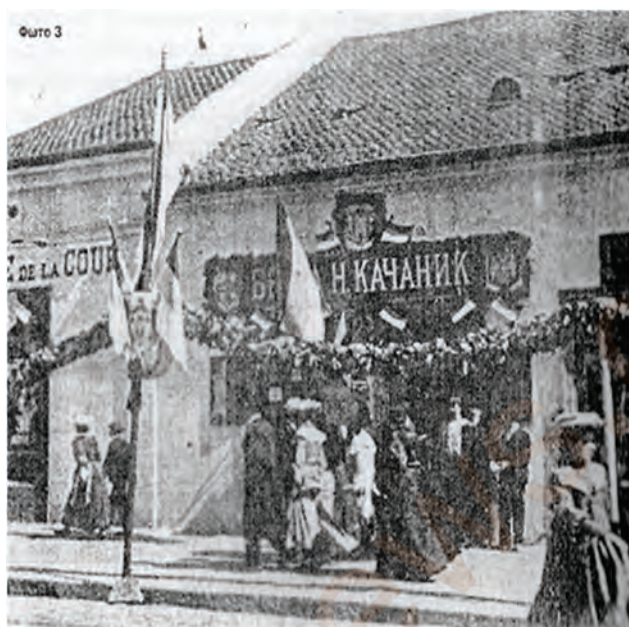
Εικ. 8.14: Το εμπορικό κατάστημα των Αδελφών Κατσάνικου στο Ποζάρεβατς της Σερβίας.
